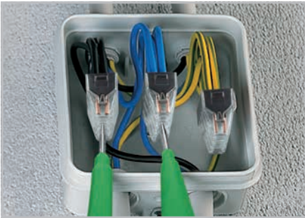
Teste de tensão através de pontos de teste separadas.
